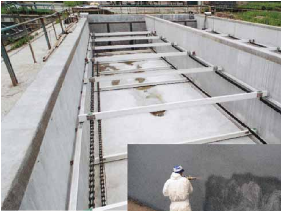
Application par projection de VANDEX POLYCEM Z
